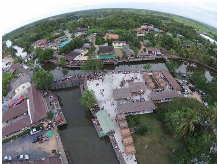
ภาพที่ 4.7 บริเวณตลาดริมน้ำคลองแดนหลังการปรับปรุงพื้นที่ พ.ศ. 2552. จาก ศูนย์ข้อมูลชุมชนคลองแดน (12 พฤศจิกายน 2559).
