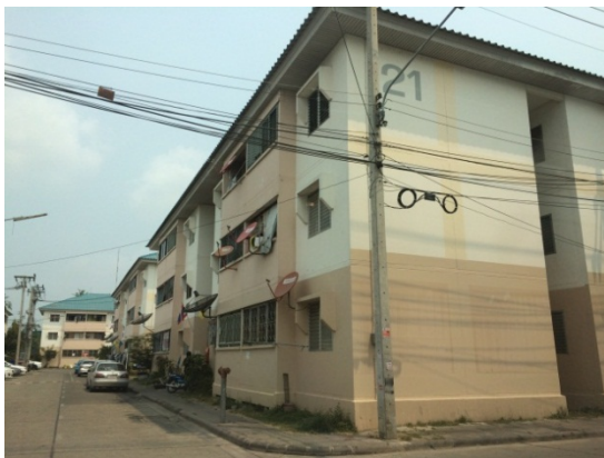
ภาพที่ 4.4 อาคารชุดพักอาศัย โครงการบ้านเอื้ออาทรพุทธมณฑลสาย 5 ตารางที่ 4.1
