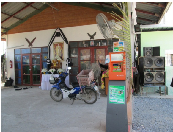
ภาพที่ 4.17 ศาลาประชุม และสภรณ์ของโครงการบ้านมั่นคงบางแก้วฟ้า
