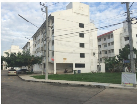
ภาพที่ 4.37 อาคารชุดพักอาศัยโครงการบ้านเอื้ออาทร
