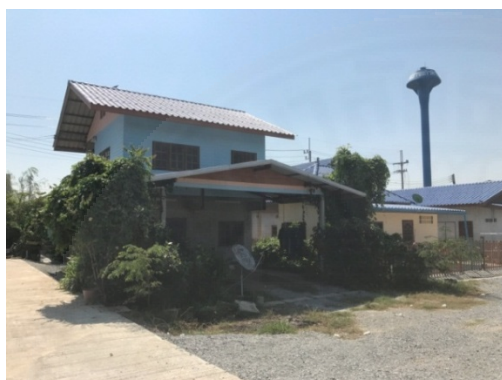
(ก) บ้านพักอาศัยโครงการบ้านมั่นคง
