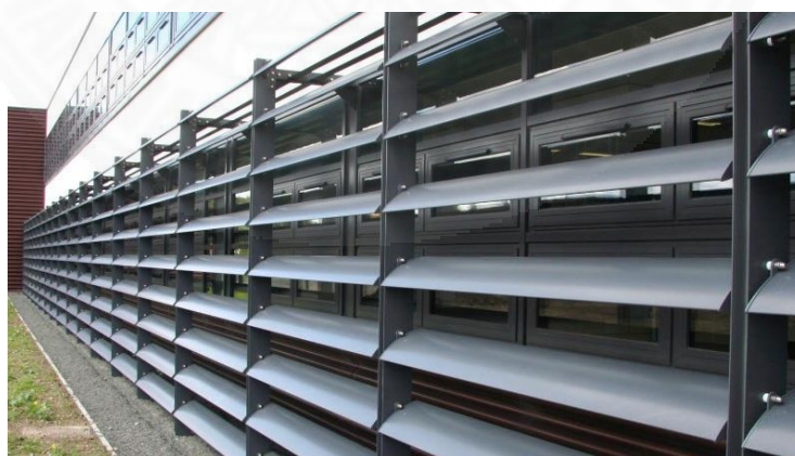
ภาพที่ 2.10 แผงกันแดด (glazed blade หรือ solar shading) จาก Levolux Limited and Levolux A.T. Limited. (2012, May 25). Levolux keeps the heat off Gateshead pupils. Retrieved November 5, 2016, from http://levolux.blogspot.com/2012/05/levolux-keeps-heat-off-gateshead-pupils.html
