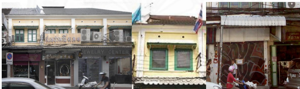
ภาพที่ 4.20 แสดงรูปด้านที่มีการเปลี่ยนแปลงวัสดุปิดผิวอาคารของตึกแถวริมถนนตะนาว ช่วงที่ 1 (ภาพซ้าย) และองค์ประกอบและวัสดุถูกเปลี่ยนแปลง(ภาพกลาง,ภาพขวา), โดยผู้วิจัย ถ่ายเมื่อ 20 มกราคม 2560.
