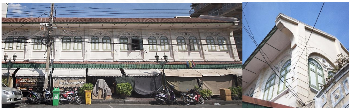
ภาพที่ 4.11 แสดงภาพรวมของกลุ่มตึกแถวริมถนนอัษฎางค์(ภาพซ้าย) และรายละเอียดของกรอบอาคารตามรูปแบบดั้งเดิม(ภาพขวา), โดยผู้จัดทำ ถ่ายเมื่อ 20 มกราคม 2560.
