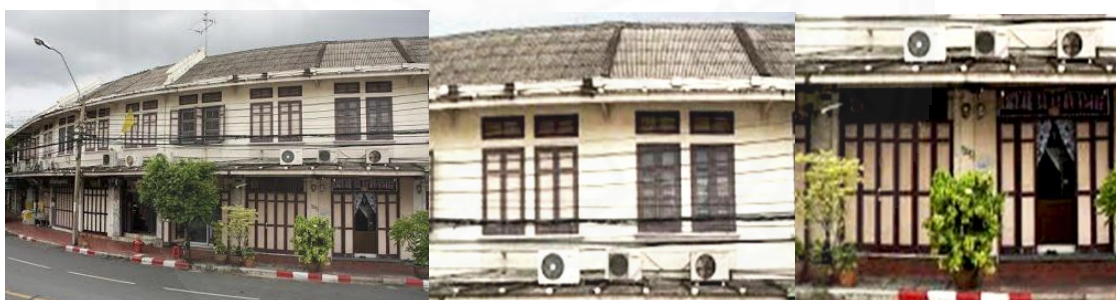
ภาพที่ 4.12 แสดงกลุ่มตึกแถวโค้งถนนพระอาทิตย์ก่อนการบูรณะ(ภาพซ้าย) และ องค์ประกอบต่อเติม (ภาพกลางและขวา) จาก ย่านเก่าในบางกอก, สืบค้นจาก https://sites.google.com/site/ibkkgroup3
