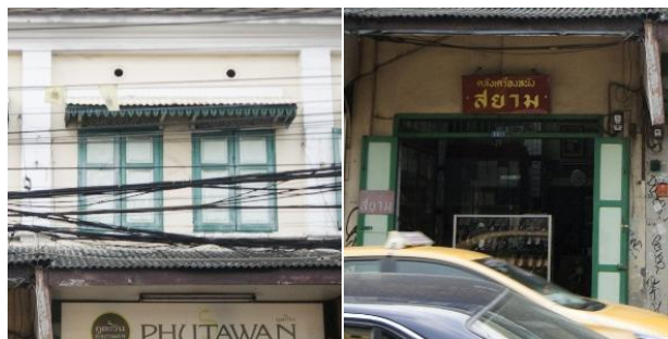
ภาพที่ 4.21 องค์ประกอบดั้งเดิมที่ยังคงหลงเหลืออยู่ในกลุ่มตึกแถว ได้แก่ หน้าต่าง ช่องลม ประตูปานเพ็ญและช่องลมเหนือประตู, โดยผู้วิจัย ถ่ายเมื่อ 20 มกราคม 2560.
