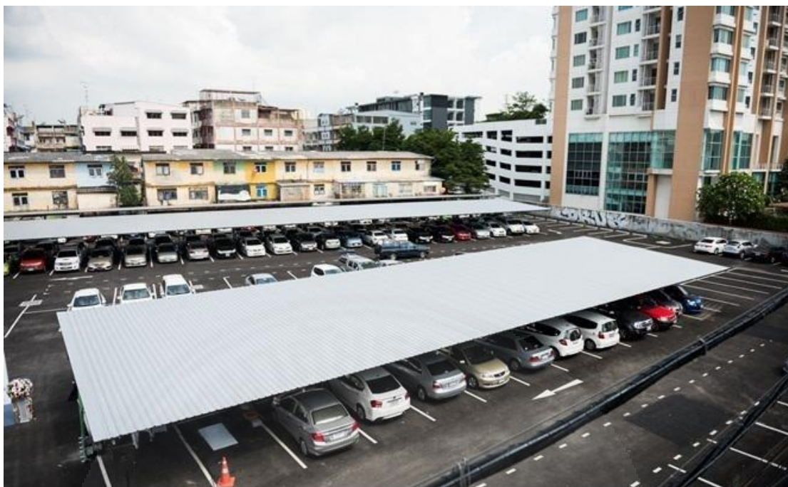
ภาพที่ 2.22 พื้นที่จอดแล้วจร สถานีกรุงธนบุรี. จาก https://www.pptvthailand.com/news/ , สืบค้นเมื่อ 2 พฤศจิกายน พ.ศ. 2559 (ดัดแปลง)
