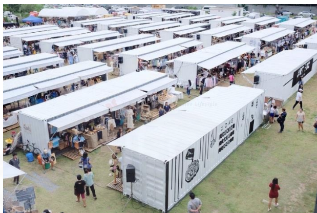
ภาพที่ 4.43 การนำตู้คอนเทนเนอร์มาดัดแปลงเป็นโครงสร้างหลักของตลาดป๊อปอัพ โดย Artbox Thailand, 2559 สืบค้นจาก http://www.forfur.com/
