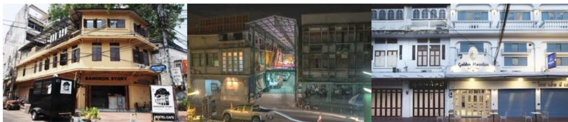
ภาพที่ 2.6 รูปแบบอาคารพาณิชย์ที่ใช้ปรับเปลี่ยนเป็นโรงแรม, จัดทำโดยผู้วิจัย, 2559
