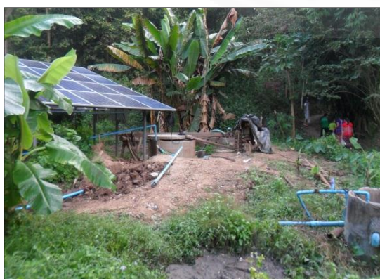
ภาพที่ 3.22 ระบบสูบน้ำพลังงานแสงอาทิตย์
