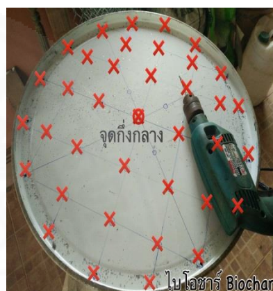
ภาพที่ 4.1 ลักษณะการเจาะรู บริเวณก้นถัง ทั้งหมด 37 รู โดย นูรีมะห์ ลูติง, 2560.
