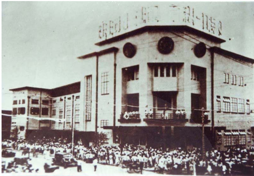
ภาพที่ 2.3 โรงภาพยนตร์ศาลาเฉลิมกรุง ที่มา: แนวหน้า. “‘นฤมล ล้อมทอง’ ผู้สร้างชีวิตให้ ‘ศาลาเฉลิมกรุง’” เข้าถึงเมื่อ 20 พฤษภาคม 2561. http://www.naewna.com/lady/303756
