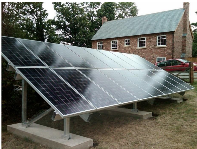
ภาพที่ 2.13 การติดตั้งบนพื้นโดยมีฐานรากคอนกรีตและโครงอะลูมิเนียม, Yanglin (Xiamen) Machinery & Technology Co.,Ltd. “4KW Ground Mounting System.” http://www.yanglinxm.com/case_detail/newsId=20.html (accessed April 18, 2017).
