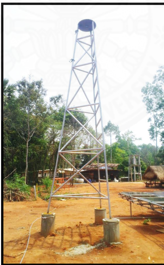
ภาพที่ 4.8 โครงถักเสารองรับแผงเซลล์แสงอาทิตย์ที่สวนป่ามหาชีวาลัยอีสาน
