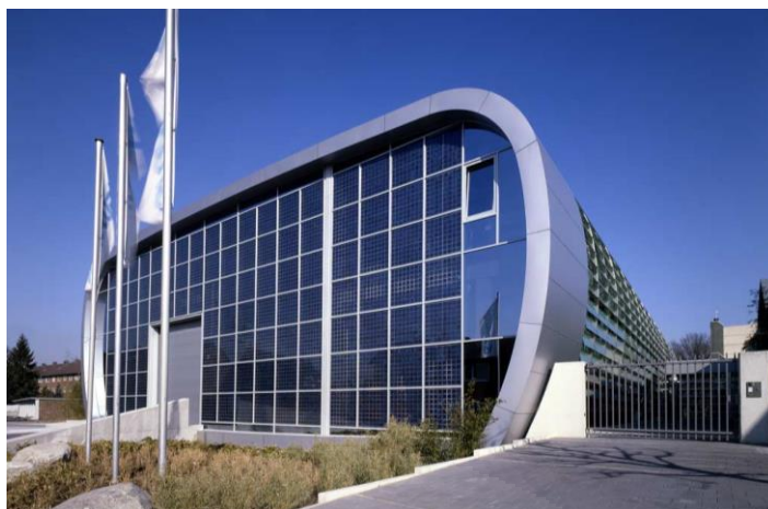
ภาพที่ 2.22 การติดตั้งเซลล์แสงอาทิตย์เพื่อเป็นผนังอาคาร, Ingenieurleistungen Manfred Starlinger. “ Building Integrated Photovoltaics ( BIPV) .” ims-plan.com/building-integrated-photovoltaics-bipv.html (accessed April 18, 2017).
