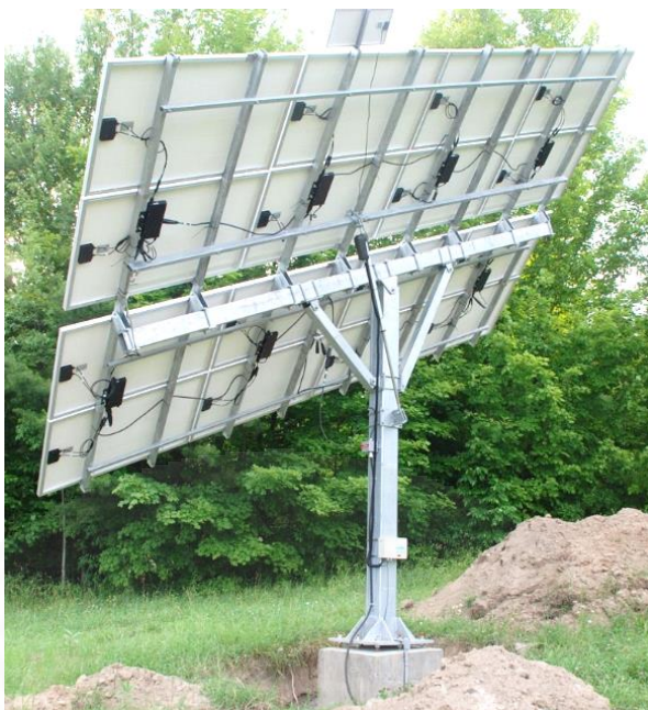
ภาพที่ 4.1 โครงสร้างรองรับแผงเซลล์แสงอาทิตย์แบบติดตามดวงอาทิตย์แกนเดียวบนเสาเดี่ยว, Ottawa Valley Photovoltaic. “Mounting Systems.” http://www.ottawavalleypv.ca/tracking_mount.html (accessed April 18, 2017).
