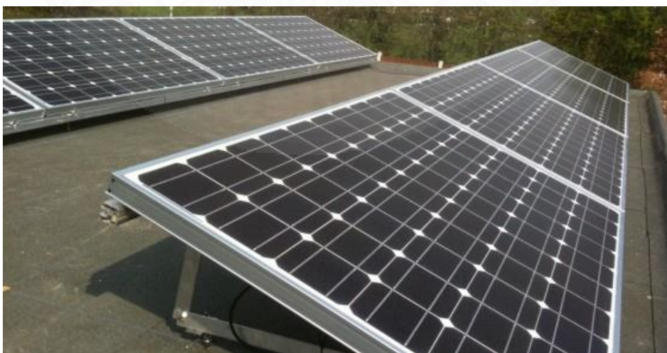
ภาพที่ 2.19 การติดตั้งเจาะยึดกับพื้นหลังคา, Ace Solar. “Solar panels fitted onto aluminium A frames for flat roofs.” http://acesolar.co.uk/portfolio_item/solar-panels-fitted-onto-aluminium/ (accessed April 18, 2017).
