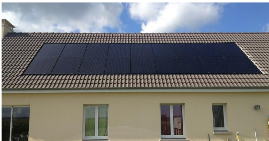
ภาพที่ 2.21 การติดตั้งแทนหลังคา, Wind & Sun Ltd. “GSE Integration Roof Integrated.” www.windandsun.co.uk/products/PV-Mounting-Structures/GSE-Integration-Roof-Integrated (accessed April 18, 2017).
