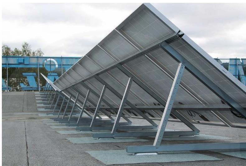
ภาพที่ 2.20 การติดตั้งโดยวางบนหลังคา, Weland Stal AB. “Fixing system for solar panels.” http://www.welandstal.se/images/galleri/be00002485.jpg (accessed April 18, 2017).
