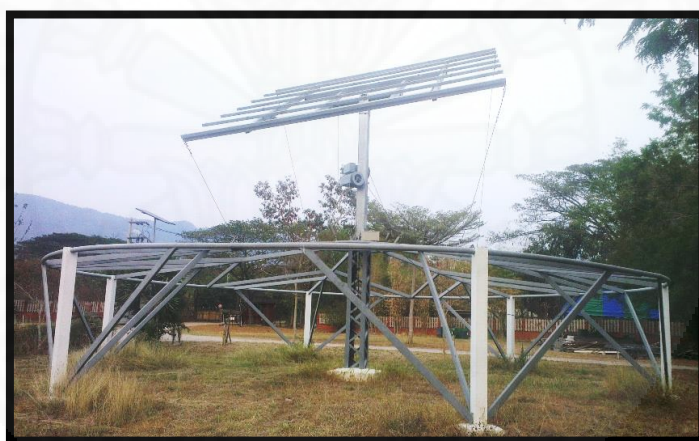
ภาพที่ 4.6 โครงสร้างรองรับแผงเซลล์แสงอาทิตย์แบบที่ติดตามดวงอาทิตย์ที่ AGLC
