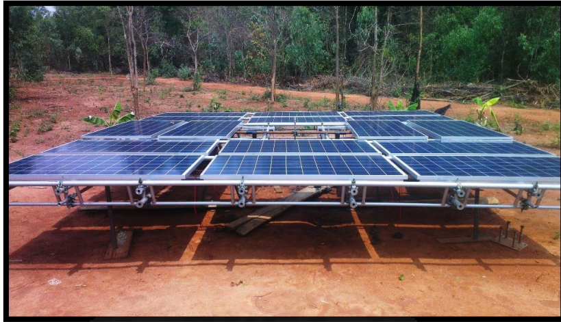
ภาพที่ 4.9 โครงสร้างรองรับแผงเซลล์แสงอาทิตย์ที่สวนป่ามหาชีวาลัยอีสาน
