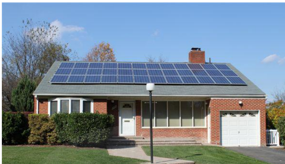
ภาพที่ 2.14 การติดตั้งบนหลังคาลาดเอียง, DWF Solar Electric. “Solar Power Technologies For the Future.” http://dfwsolarelectric.com/blog/ (accessed April 18, 2017).
