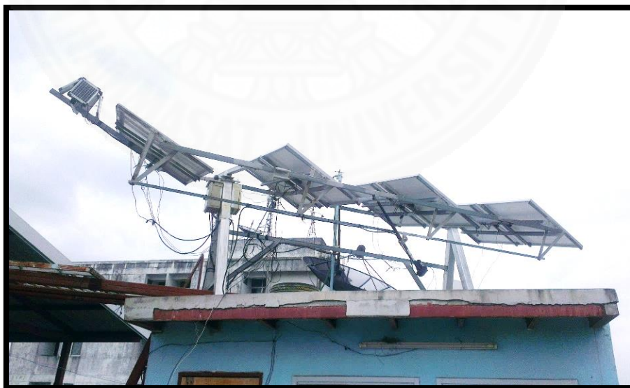
ภาพที่ 4.11 การติดตั้งโครงสร้างบนอาคารเวรตี 47 อพาร์ทเมนต์
