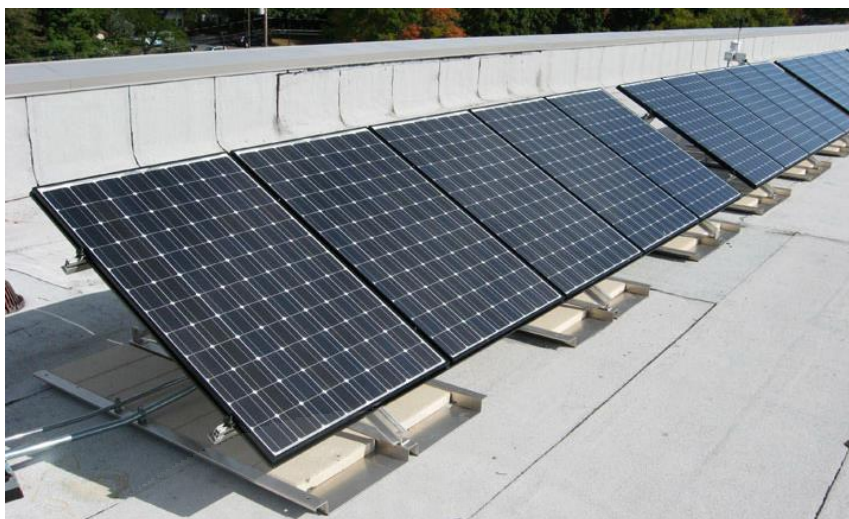
ภาพที่ 2.18 การติดตั้งบนฐานน้ำหนักร่อง, Connecticut Innovations. “Learning for Clean Energy Innovation.” www.sunviewer.net/portals/CCEF/ (accessed April 18, 2017).
