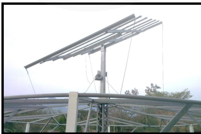
ภาพที่ 4.7 มอเตอร์ที่ยึดกับสายเคเบิลเพื่อขับเคลื่อนโครงสร้างรองรับแผงเซลล์แสงอาทิตย์ที่ AGLC
