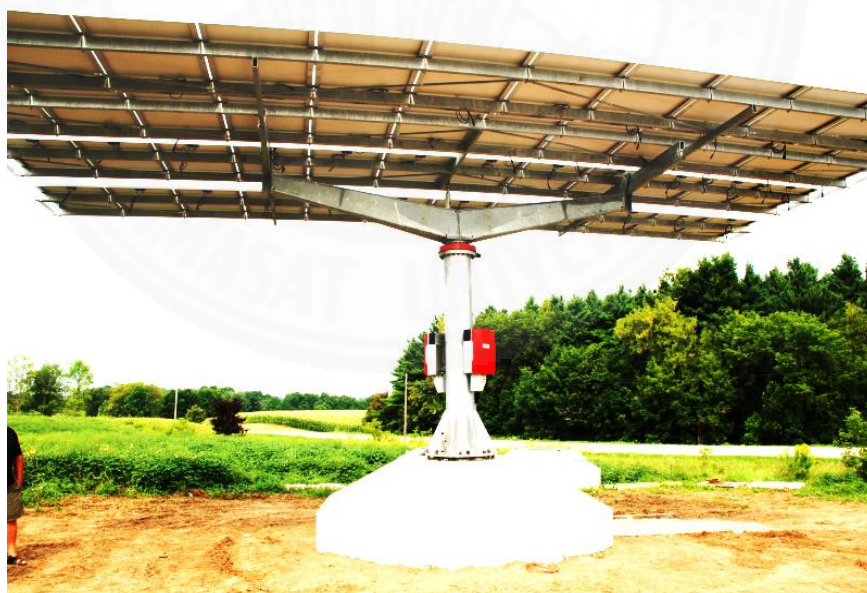
ภาพที่ 4.2 โครงสร้างรองรับแผงเซลล์แสงอาทิตย์แบบติดตามดวงอาทิตย์สองแกนบนเสาเดี่ยว, เรื่องเดียวกัน, 51.
