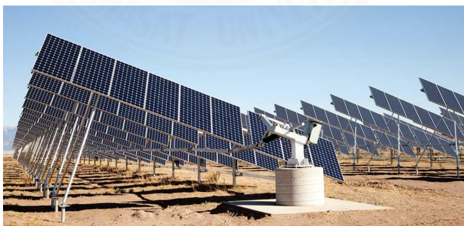
ภาพที่ 4.4 โครงสร้างรองรับแผงเซลล์แสงอาทิตย์แบบติดตามดวงอาทิตย์แกนเดียวบนพื้น, Stephen Smith. “ PV Trackers.” http://solarprofessional.com/articles/products-equipment/racking/pv-trackers#.WdsRbzBx3Dc (accessed June 21, 2017).
