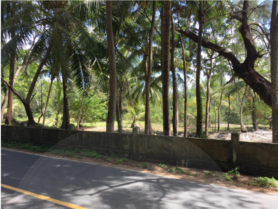
ภาพที่ 2.7 สภาพที่ดินปัจจุบันมีแนวรั้วเดิม
