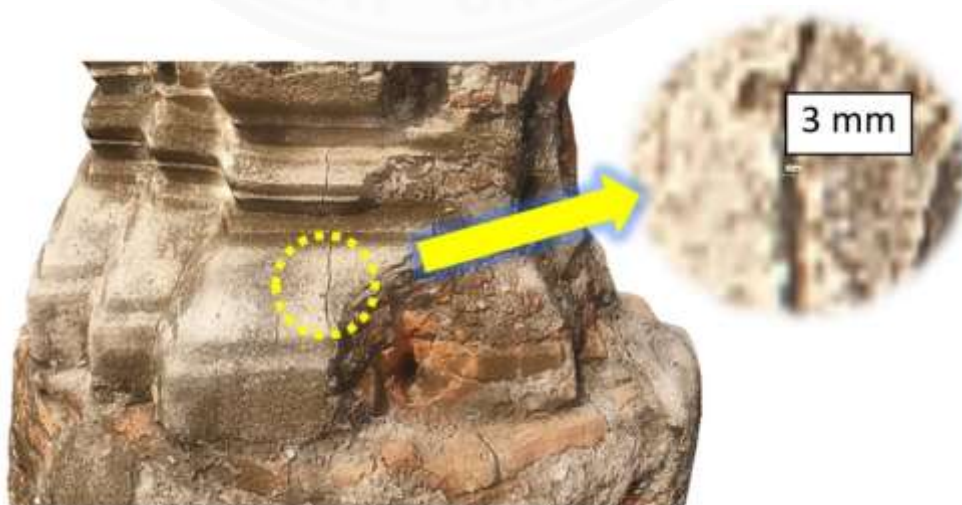
ภาพที่ 4.35 ตัวอย่างการระบุขนาดความกว้างของรอยร้าวบนแบบจำลองสามมิติ
