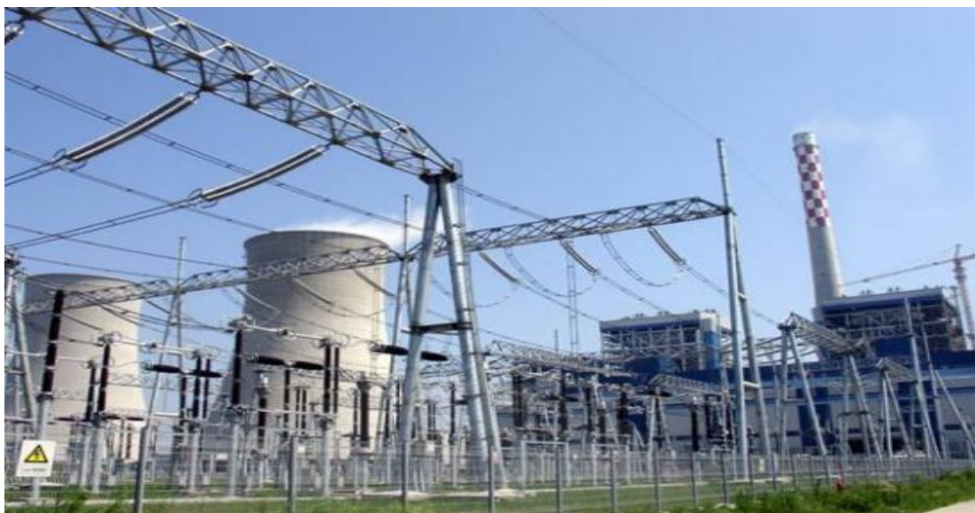
ภาพที่ 2.2 พลังงานไฟฟ้า
