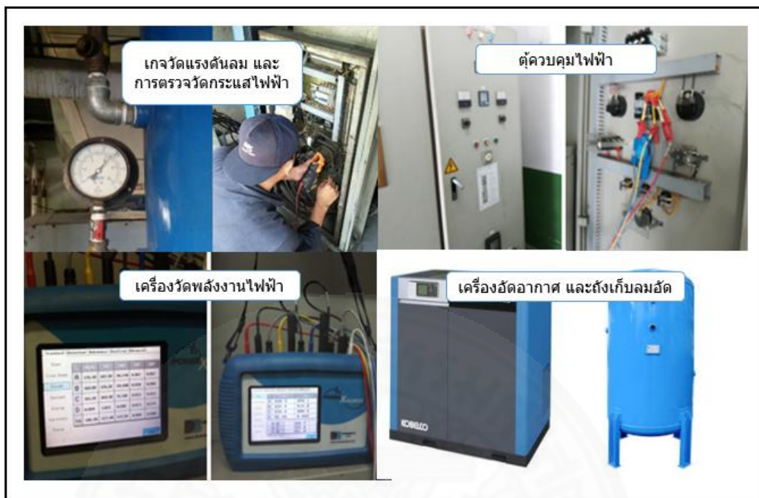
ภาพที่ 4.4 การตรวจวัดพลังงานไฟฟ้าก่อน และหลังดำเนินงานด้วยเครื่องวัดพลังงานไฟฟ้า
