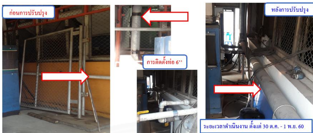
ภาพที่ 4.2 การเปลี่ยนขนาดท่อส่งลมอัดให้มีขนาดใหญ่ขึ้น จากเดิม 2 นิ้ว มาเป็น 6 นิ้ว
