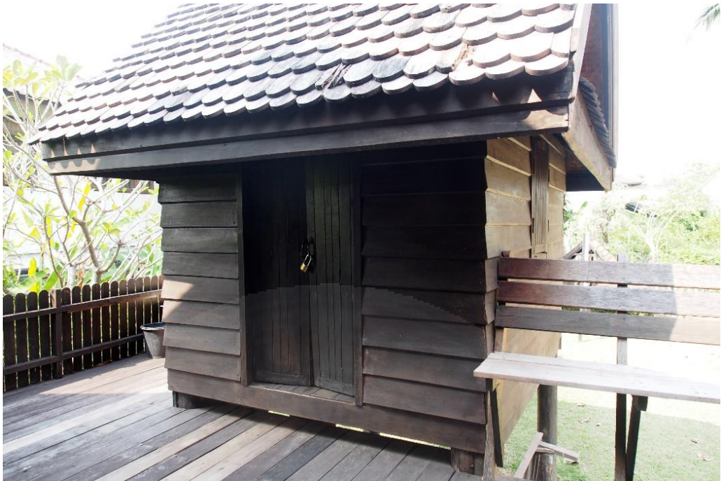
ภาพที่ 4.19 เรือนครัวที่แยกออกมาจากรือนนอน โดยมีชานเป็นส่วนเชื่อม
