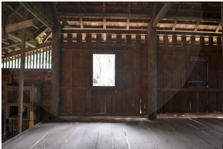
ภาพที่ 4.17 บริเวณภายในเรือนโคราช
