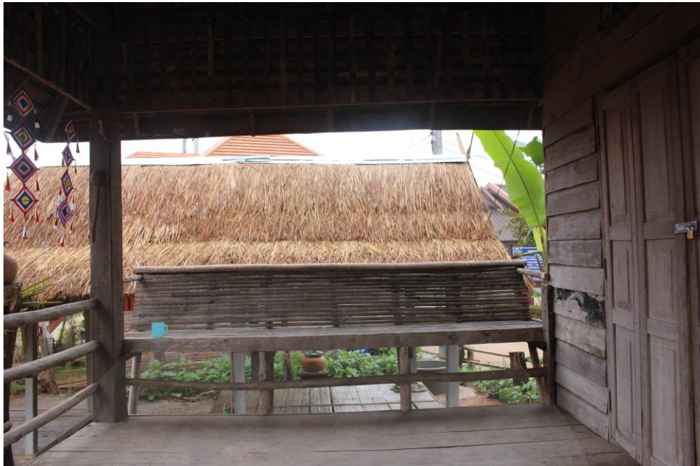
ภาพที่ 4.6 ด้านหน้าประตูทางเข้าเรือนหลัก
