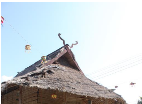
ภาพที่ 4.9 ส่วนของชอกูด้านบน ทำจากไม้แคะสลักคล้ายเขากวาง
