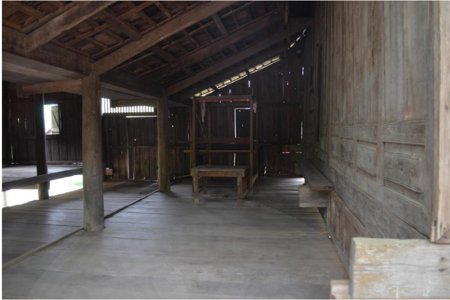
ภาพที่ 4.16 บริเวณภายในเรือนโคราช
