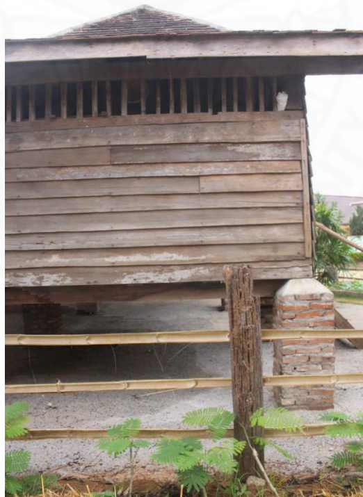
ภาพที่ 4.7 ลักษณะของฝาเรือน ฝาไม้กระดาน เรียกว่า ไม้แป้น
