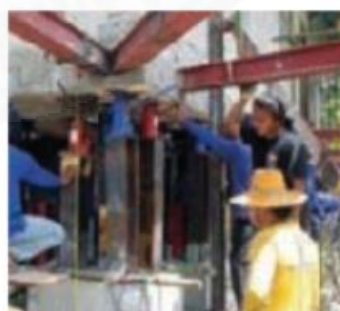
ภาพที่ 2.36 วิธีการแก้ปัญหาความชื้นโดยการยกหรือย้ายอาคารของวัดเขมาภิรตาราม จังหวัดนนทบุรี (ที่มา: การทำนุบำรุง วัด ศาสนสถาน ศาสนวัตถุ และศิลปวัตถุ. โดย สำนักงานทรัพย์สินส่วนพระมหากษัตริย์)
