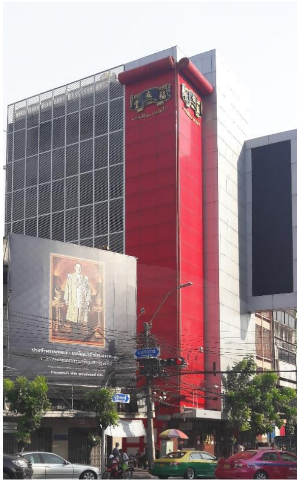
The use of red color on the façade / การใช้สีแดงตกแต่งอาคาร
