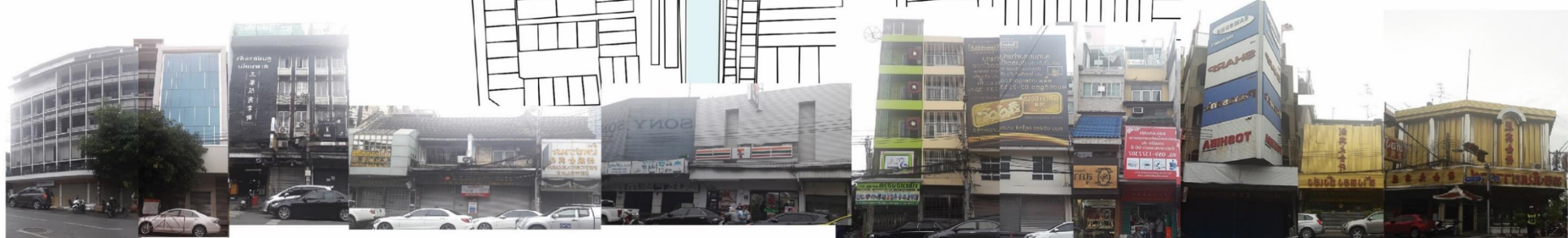
ภาพที่ 4.24 แสดงรูปแบบทางสถาปัตยกรรมของอาคารบนถนนเยาวราชช่วงระหว่างแยกจักรวรรดิถึงคลองโอ่งอ่าง
