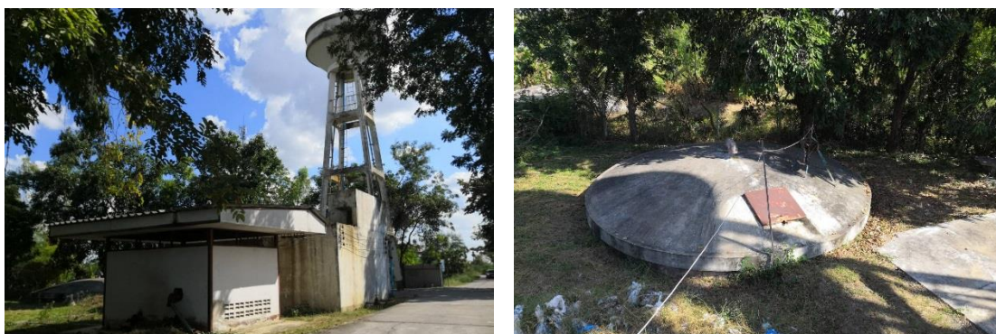
ภาพที่ 3.6 ระบบหอถังสูงและระบบถังน้ำใสประปาหมู่ที่ 7 ที่มา: การสำรวจระบบประปาหมู่ที่ 7 บ้านปราสาทใต้
