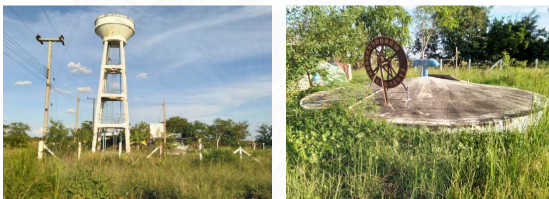
ภาพที่ 3.6 ระบบหอถังสูงและระบบถังน้ำใสประปาหมู่ที่ 7 ที่มา: การสำรวจระบบประปาหมู่ที่ 7 บ้านปราสาทใต้
