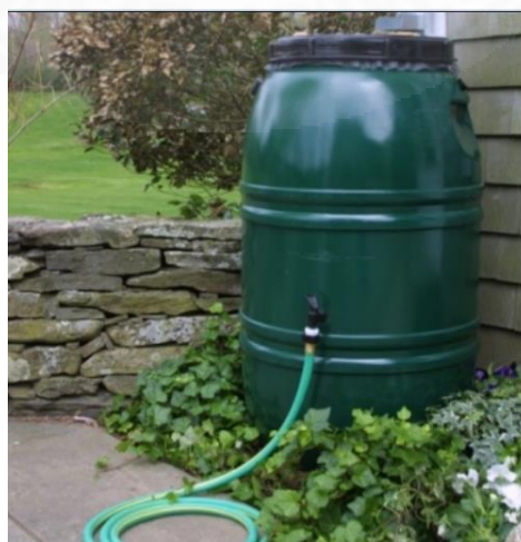
ภาพที่ 2.7 ถังเก็บน้ำฝน (Rain Barrels), โดย United States Environmental Agency, 2004.
