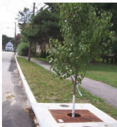
ภาพที่ 2.10 การใช้ช่องต้นไม้เป็นตัวกรองน้ำ (Tree Filters), โดย United States Environmental Agency, 2004.
