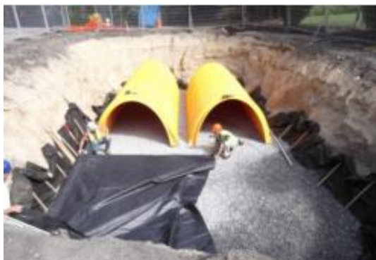
ภาพที่ 2.2 กรอบออกแบบพื้นที่แบบโพรงใต้ดิน (Underground Chambers), โดย United States Environmental Agency, 2004.
