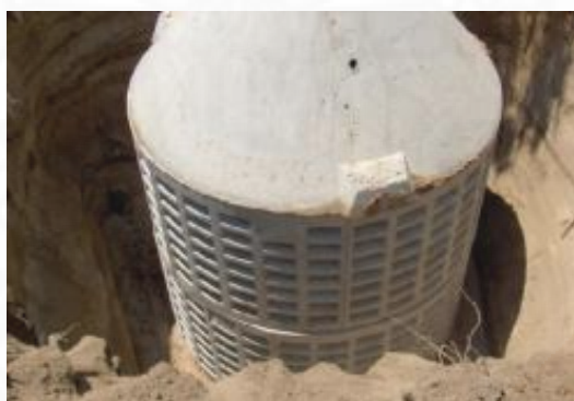
ภาพที่ 2.3 การออกแบบบ่อแห้ง (Dry Wells), โดย United States Environmental Agency, 2004.
