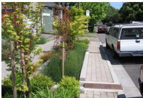
ภาพที่ 2.9 การกักเก็บน้ำด้วยกระถางพืช (Stormwater Planters), โดย United States Environmental Agency, 2004.
