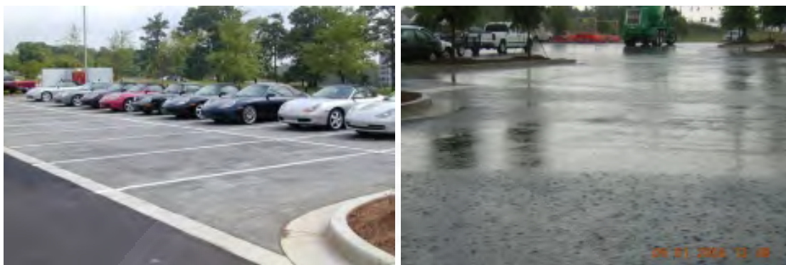
ภาพที่ 2.17 ลานจอดรถที่ใช้เทคโนโลยีคอนกรีตพรุน. สืบค้นจาก http://secement.org/products/pervious-concrete/ .
