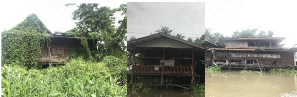
ภาพที่ 4.33 ที่อยู่อาศัยที่ถูกทิ้งร้างในพื้นที่ชุมชนดั้งเดิมริมคลองอ้อมนนท์
