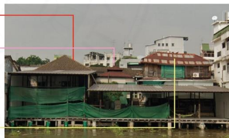
① หลังคาสังกะสี บริเวณลาน
