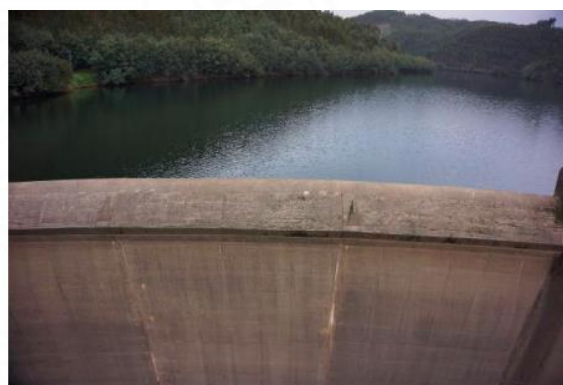
ภาพที่ 2.10 ผนังท้ายเขื่อนและทางระบายน้ำล้นเขื่อน Bouçã (อ้างอิงจาก Maria João Henriques และ Dora Roque (2015))
