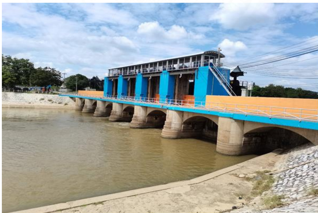
ภาพที่ 3.4 ภาพถ่ายปัจจุบันประตูระบายน้ำพลเทพ
