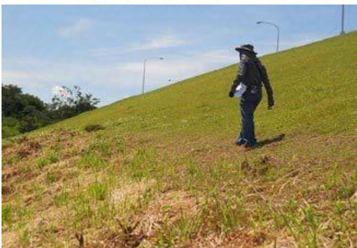
ภาพที่ 4.11 การเดินสำรวจและบันทึกการให้คะแนนตามสภาพของอาคารชลประทานเขื่อนดิน (อ้างอิงจาก คณะทำงานโครงการเพิ่มพูนทักษะด้านความปลอดภัยเขื่อนเชิงปฏิบัติการ การตรวจสอบสภาพเขื่อนด้วยสายตาและประเมินผลโดยดัชนีสภาพ (2554))
