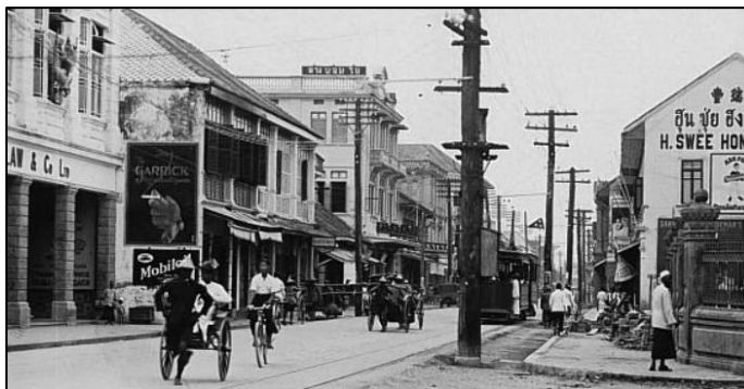
ภาพที่ 4.7 ถนนเจริญกรุงในอดีต. จาก Wikiwand, 2565, ปรับปรุงโดยผู้วิจัย, 2565.
