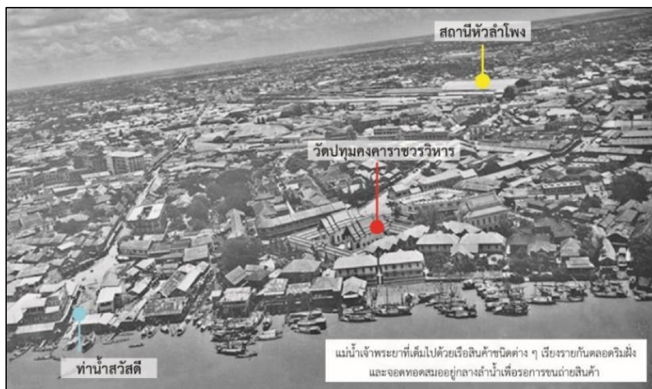
ภาพที่ 4.1 การค้าขายริมแม่น้ำเจ้าพระยาของชุมชนตลาดน้อย บริเวณวัดปทุมคงคาราชวรวิหาร. จาก นิติยสารศิลปวัฒนธรรม, 2564, ปรับปรุงโดยผู้วิจัย, 2565.
