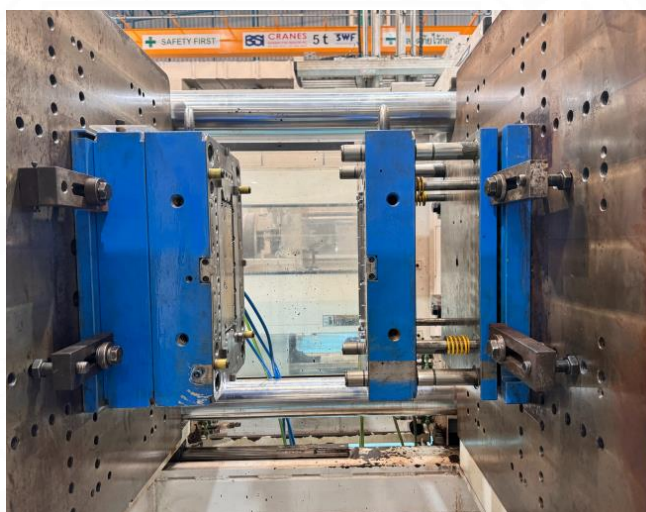
ภาพที่ 4.13 การติดตั้งแม่พิมพ์บนเครื่องจักร
