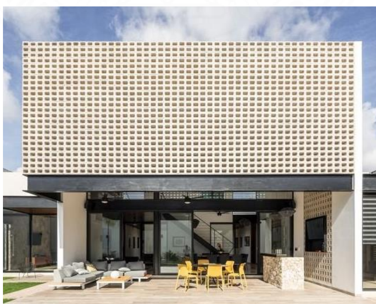
ภาพที่ 2.55 เปลือกอาคารอิฐช่องลม. จาก https://www.smartblock.co.th/content .
