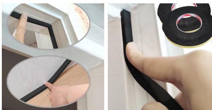
ภาพที่ 5.8 การติดตั้งซีลยางที่หน้าต่าง. จาก https://www.ptiglobalproducts.co.th .
