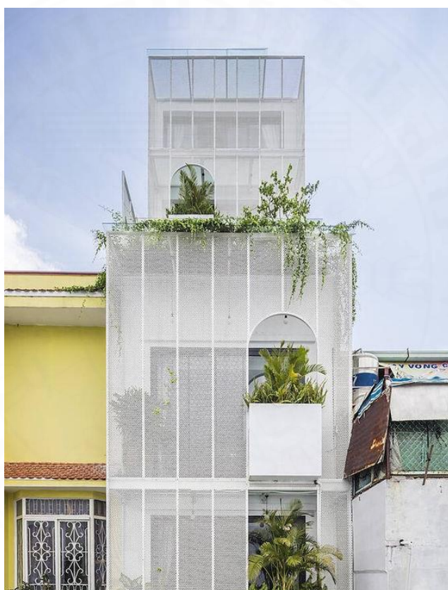
ภาพที่ 2.56 เปลือกอาคารตะแกรงเหล็กฉีก. จาก https://www.vpexpand.com .
