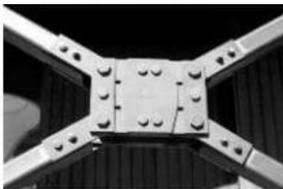
ภาพที่ 2.105 Friction Dampers. จาก https://theconstructor.org/earthquake/seismic-dampers/8332/ .
