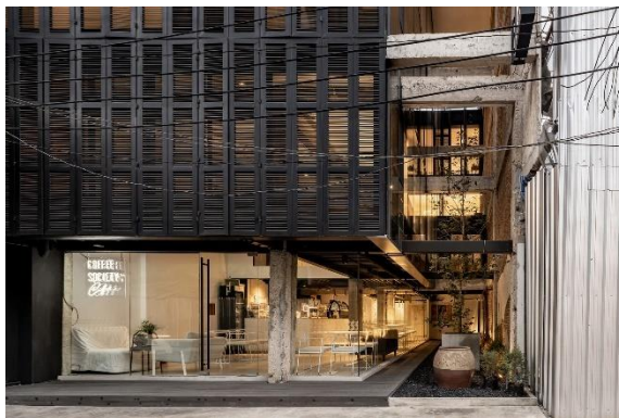
ภาพที่ 2.34 ภาพแนวแสดงส่วนที่รีโอโครงสร้างพื้นออก. จาก เกตน์สิริ วงศ์วาร, 2561.
