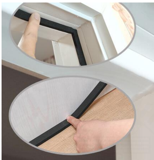
ภาพที่ 2.102 การซีลยางที่ขอบประตูและหน้าต่าง. จาก https://www.acousticexpert.co .
