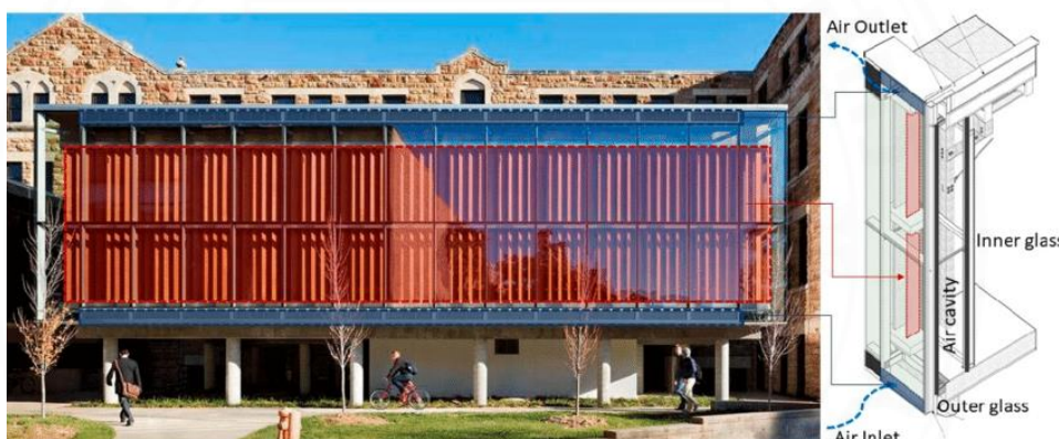
ภาพที่ 2.46 Double-Skin Facade. จาก https://www.researchgate.net/figure/Double-skin-facade-building-at-the-University-of-Kansas-source .
