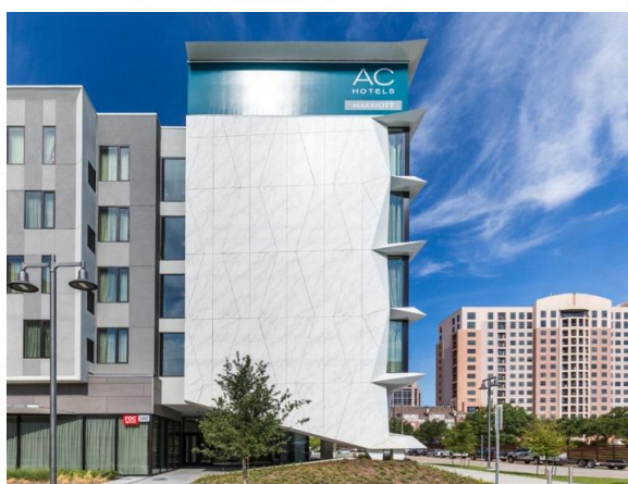
ภาพที่ 2.50 เปลือกอาคารหินอ่อนเทียม. จาก https://dsignsomething.com .
