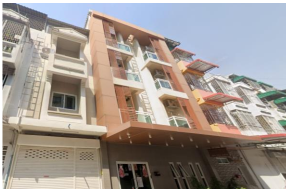
ภาพที่ 2.29 ภาพหลังปรับปรุงอาคารตึกแถว. จาก https://www.google.com/maps .
