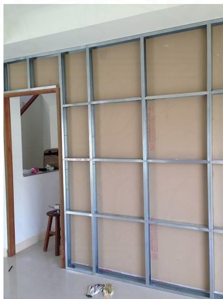
ภาพที่ 2.119 การเตรียมติดตั้งผนังเบาอิพซัมบอร์ด. จาก https://images.app.goo.gl .
