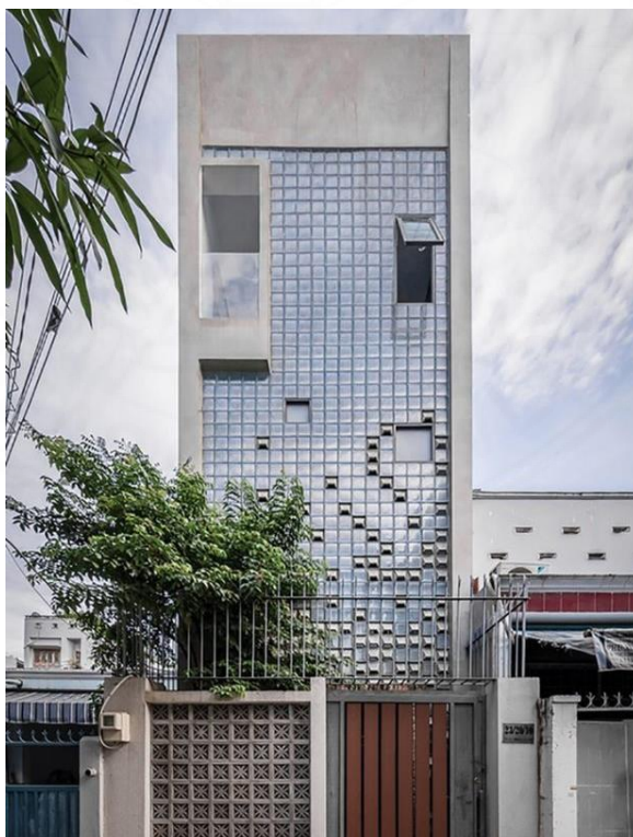
ภาพที่ 2.63 เปลือกอาคารบล็อกแก้ว. จาก https://www.banidea.com/glass-brick-townhouse-zen-villas-vietnam/ .
