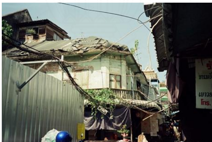
ภาพที่ 4.9 หลังคาที่ชำรุดเสียหายของตึกแถวเจริญไชยของคูหาที่จัดแสดงบ้านเก่าเล่าเรื่อง, จาก เพจบ้านเก่าเล่าเรื่องชุมชนเจริญไชย. (2566, 23 พฤษภาคม). สืบค้นโดยผู้วิจัย, 2567.
