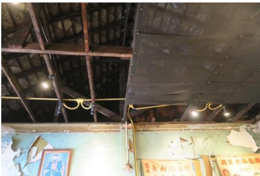
ภาพที่ 4.10 ฝาเพดานที่ถูกรื้อถอน เหลือแต่โครงสร้างหลังคา บางส่วนใช้ผ้าขึงทดแทน, โดยผู้วิจัย, 2567.
