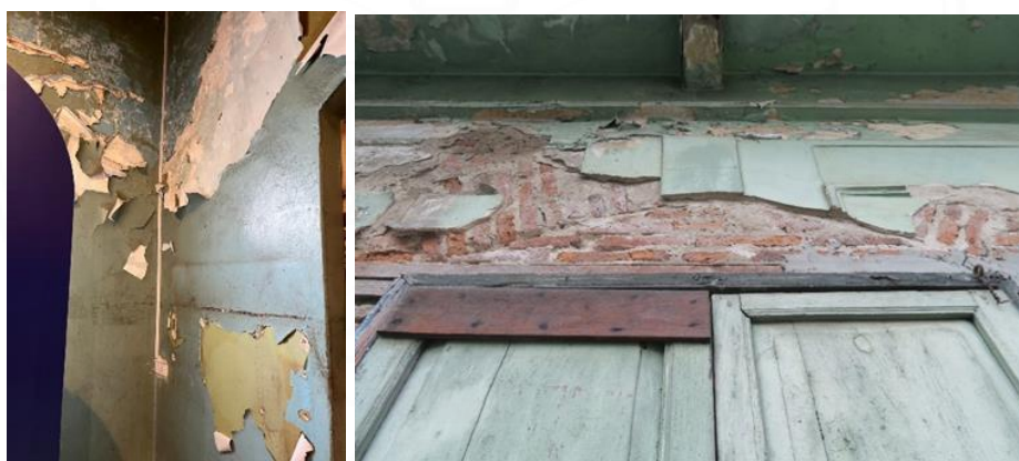
ภาพที่ 4.11 ผนังของตึกแถวเจริญไชยในส่วนของพื้นที่บ้านเก่าเล่าเรื่อง เกิดการผุกร่อนและสีเคลือบผิวหลุดลอกตามกาลเวลา, โดยผู้วิจัย, 2567.
