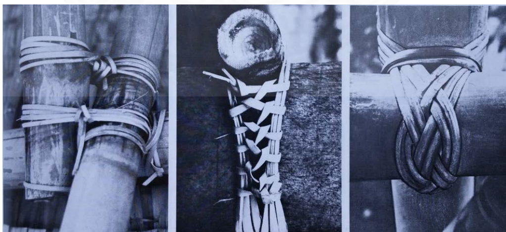
ภาพที่ 5.25 การใช้เชือกหรือวัสดุอื่นๆพันทับบริเวณที่ทำการเจาะเพื่อลดความเสียหายจากการแตกของไม้. IL31 Bambus-Bamboo (p. 117), Institute for Lightweight Structure, 1985, Stuttgart, Germany.
