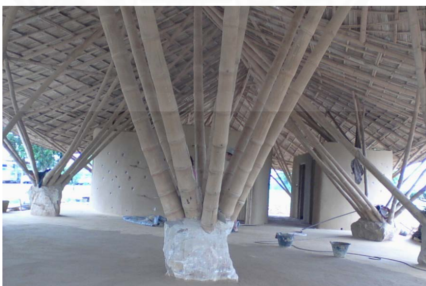
ภาพที่ 5.27 ฐานรากคอนกรีตของโครงสร้างไม้ไม้ที่โรงเรียนปัญญาประทีป จังหวัดนครราชสีมา
