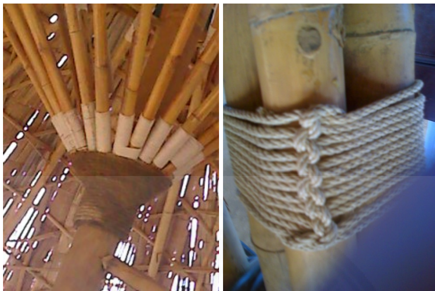
ภาพที่ 5.26 การใช้เชือกพันทับบริเวณที่ทำการเจาะเพื่อลดความเสียหายจากการแตกของไม้ โรงเรียนปัญญาเด่น จังหวัดเชียงใหม่
