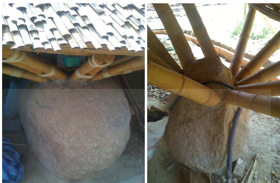
ภาพที่ 5.28 ฐานรากหินของโครงสร้างไม้ไผ่ โรงเรียนปัญญาเด่น จังหวัดเชียงใหม่
