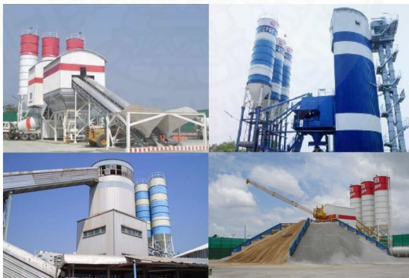
ภาพที่ 2.1 บริเวณภายในโรงงานผลิตคอนกรีตผสมเสร็จ จาก คู่มือมาตรฐานการตรวจสอบ โรงงานผลิตคอนกรีตผสมเสร็จ, โดย กรมโรงงานอุตสาหกรรม, 2549.
