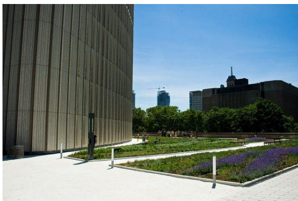
ภาพที่ 3.2 Green Roof บนหลังคาอาคาร Toronto City Hall
