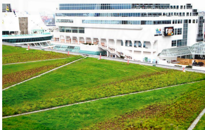
ภาพที่ 3.3 Green Roof บนหลังคาอาคาร Vancouver Convention Centre
