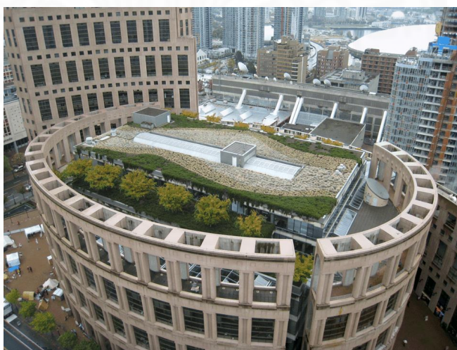
ภาพที่ 3.4 Green Roof บนหลังคาอาคาร Vancouver Public Library
