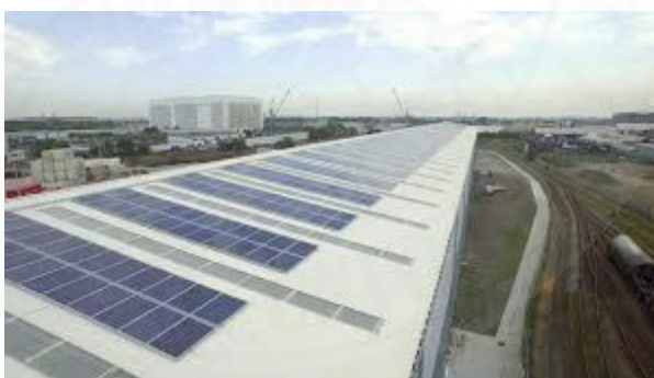
ภาพที่ 6.2 การติดตั้งแผงโซล่าเซลล์บนหลังคาอาคารคลังสินค้า
