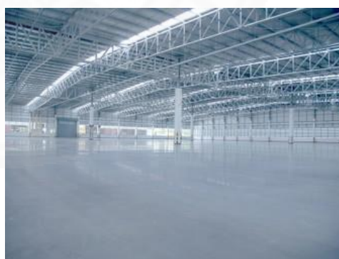
แสดงรูปแบบพื้นคลั่งสินค้า Burnished Floor
