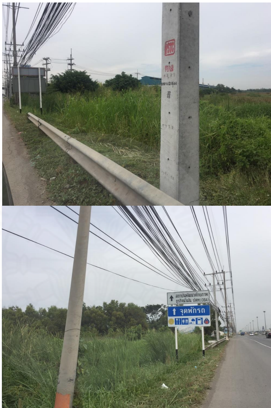
ภาพที่ 2.5 บริเวณด้านหน้าโครงการติดถนนพหลโยธิน
