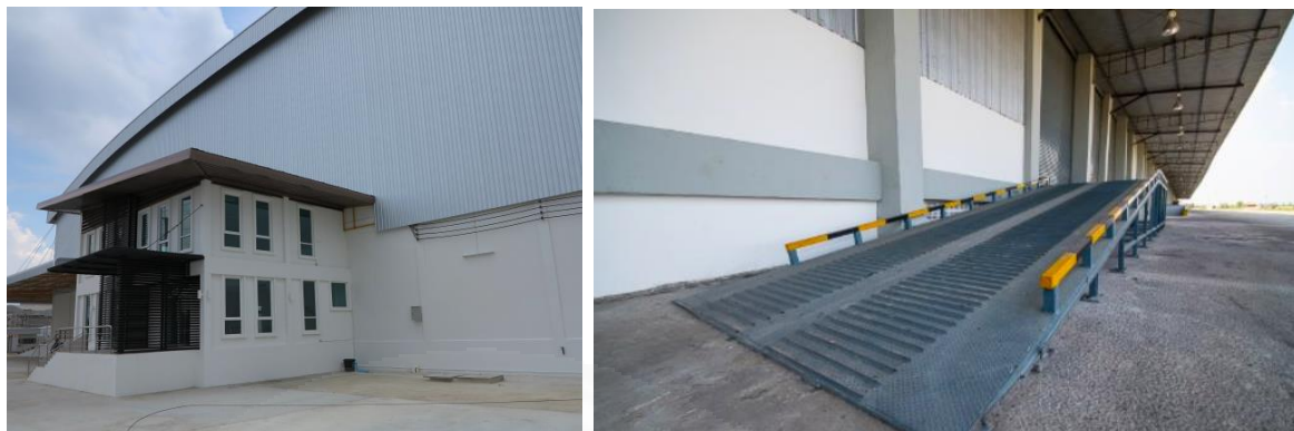
ภาพที่ 5.5 แสดงรูปภายในคลังสินค้า KMCA และพื้นที่โดยรอบคลังสินค้า
