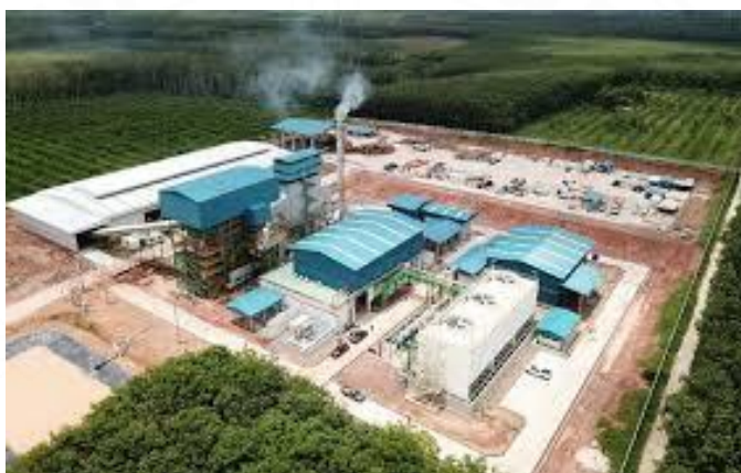
ตัวอย่างโรงไฟฟ้าพลังงานชีวมวล
