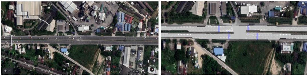
ภาพที่ 2.15 โครงข่ายถนนจริงและโครงข่ายถนนในแบบจำลอง
