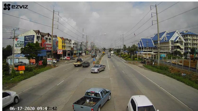
ภาพที่ 3.2 ทางหลวงหมายเลข 346 กม. 23+990
