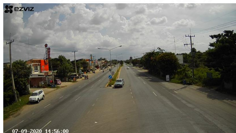
ภาพที่ 3.3 ทางหลวงหมายเลข 226 กม. 6+546
