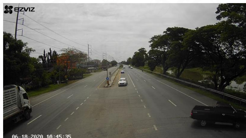
ภาพที่ 3.5 ทางหลวงหมายเลข 304 กม. 38+500
