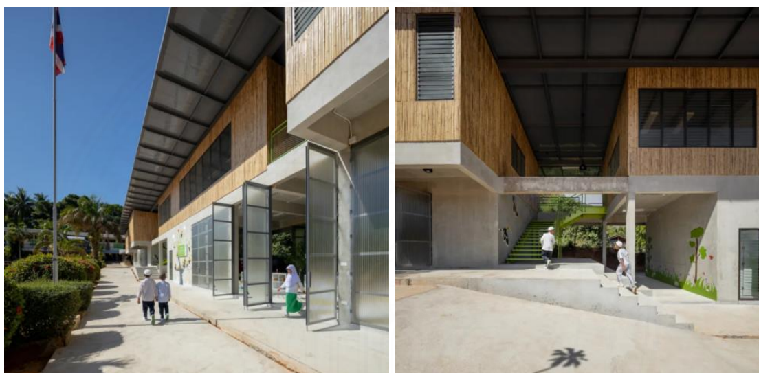
ภาพที่ 2.28 ทางเดินด้านหลังอาคารโรงเรียนบ้านคลองบอน. สืบค้นจาก
