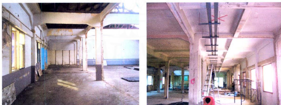
รูปที่ 4-7 ภายในอาคารราชดำเนิน อาคาร 1: โครงสร้างคอนกรีตเสริมเหล็กแบบโครงข้อแข็ง (rigid frame) ผสมกับแบบเสาและคานธรรมดาบางช่วง
