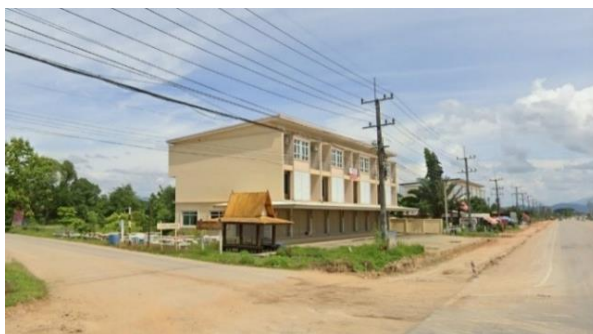
ภาพที่ 4.2 ทางเข้าจากถนนหลวงเข้าสู่ซอยไปโครงการ. จาก Google Earth. โดยผู้วิจัย, 2566.
